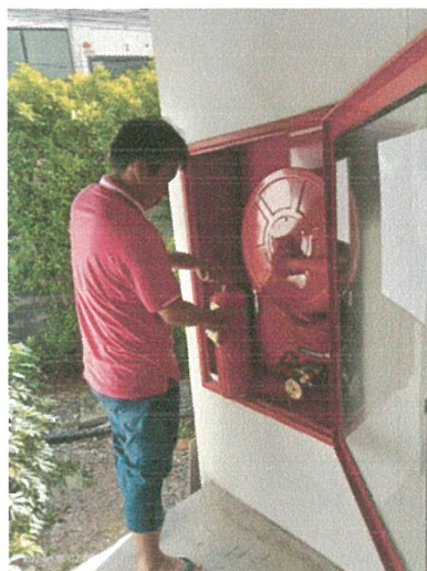
รูปภาพที่ 2.39 การตรวจสอบอุปกรณ์ป้องกันและระงับอัคคีภัย
