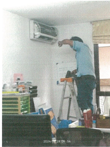
รูปภาพที่ 2.40 ล้างทำความสะอาดเครื่องปรับอากาศ
