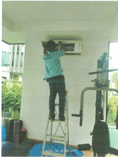
รูปภาพที่ 2.40 ล้างทำความสะอาดเครื่องปรับอากาศ
